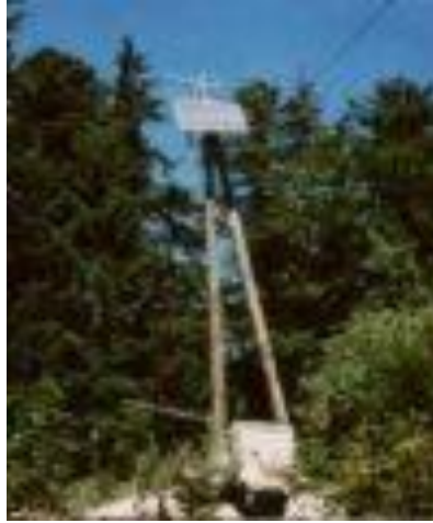
Telefon ob cesti za klice v sili (Vir/Copyright: Sandia National Laboratories ), Radijska povezava napajana s fotonapetostnim sistemom
